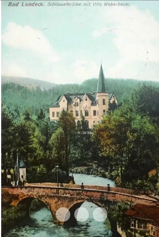
Bad Landeck. Schlüsselbrücke mit Villa Weberbauer.
